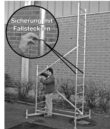
Grundgerüst mit erster Aufstockung
