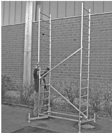
Grundgerüst mit erster Aufstockung
