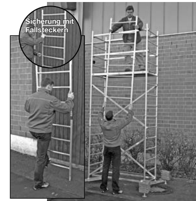
Grundgerüst mit erster und zweiter Aufstockung
