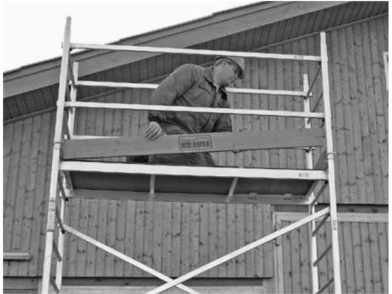
Die Abbildung zeigt das fertig montierte Gerüst mit einer Arbeitshöhe von 5,80 m.
