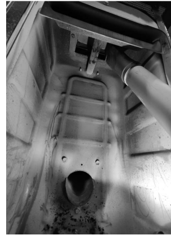
Fig. 77 - Die Asche absaugen
