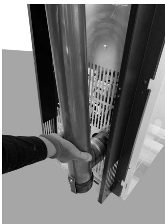
Fig. 41 - Rohr Durchm. 80 mm einstecken
