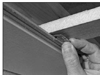
Befestigungskralle setzen
