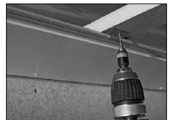
Befestigungskralle anschrauben
