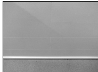
Deckenabschlussleisten aufstecken – fertig
