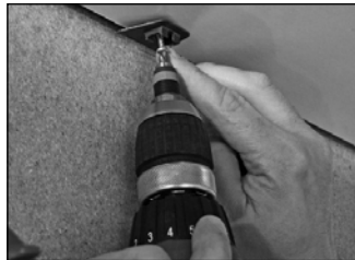
Leistclip montieren
