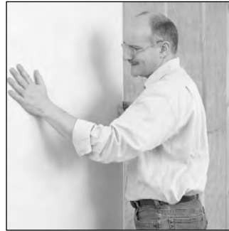
Einsetzen erste Platte
