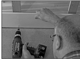
Erstes Steck-Paneel befestigen
