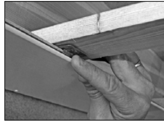
Befestigungskralle setzen
