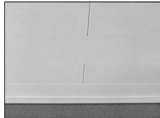
Deckenabschlussleisten aufstecken – fertig
