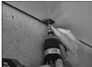
Leistclip montieren
