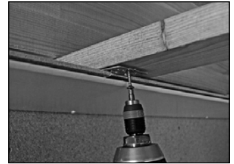
Befestigungskralle anschrauben
